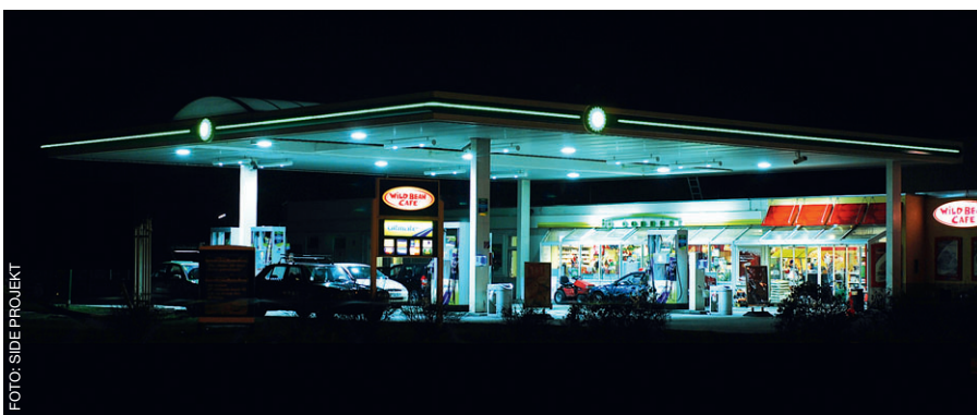
LED-Beleuchtung an Tankstellen reduziert den Stromverbrauch und die Servicekosten.
